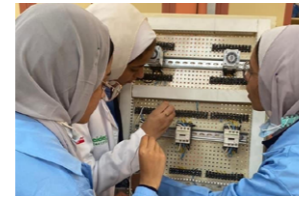
P. 86 - Techniciennes au travail ©IECDEGYPT
